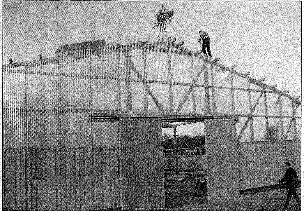
Die neue Reithalle auf „Hof Grüneberg“ gibt ein imposantes Bild ab. Noch fehlen das Dach und die Außenverkleidung. Unmittelbar vor der Halle wird ein Reitplatz entstehen. FOTOS (2): WITTKÉ
